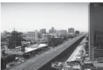
รูปที่ 1-3 ปูนซีเมนต์เป็นวัสดุก่อสร้างที่นิยมใช้กันอย่างแพร่หลาย อาทิงานหล่อคอนกรีตสำหรับการก่อสร้างอาคาร, ถนน, และสะพาน
